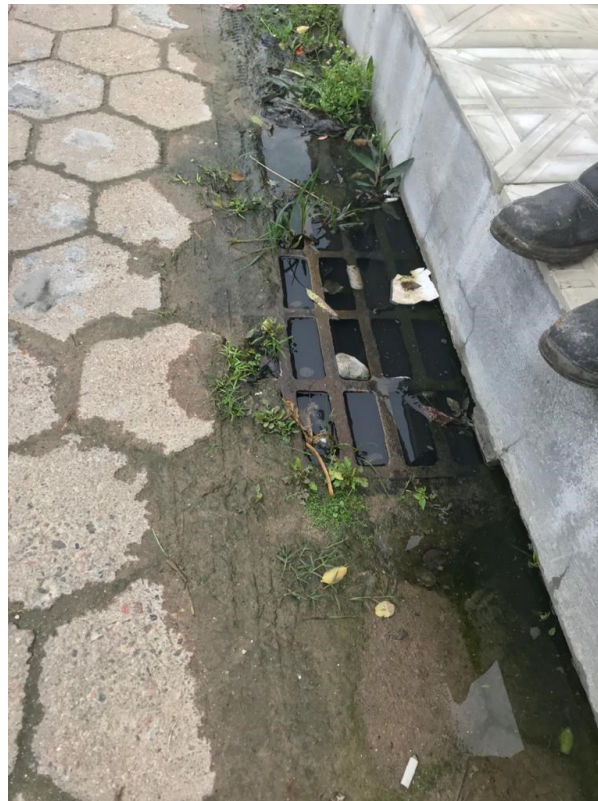
Figura 5 – boca de lobo entupida – UTP 13.
