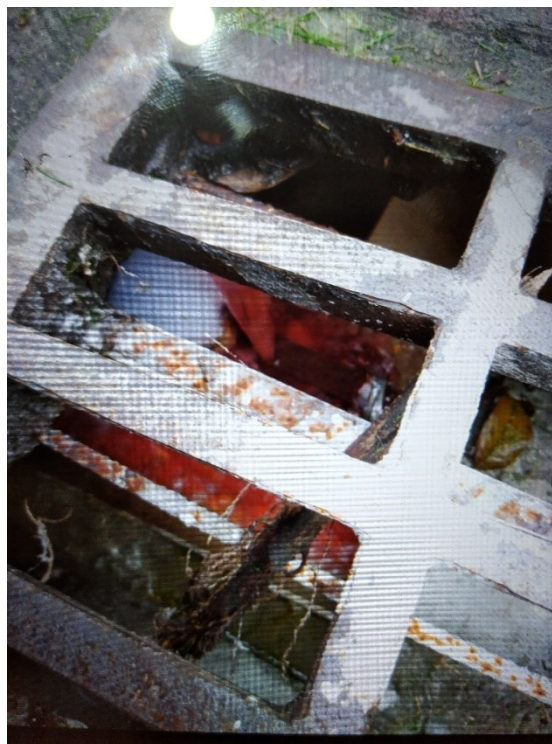
Figura 4 – Corante vermelho indicando o lançamento de esgoto clandestino na drenagem pluvial – UTP 13.
