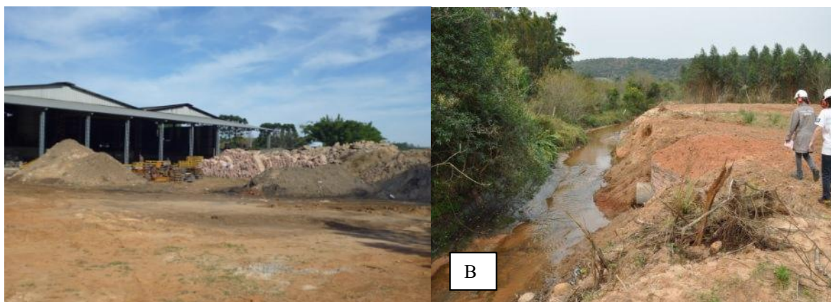
Figura 5 - A) Descarte do resíduo AF no pátio da empresa. B) Descarte de resíduo de AF até a margem do arroio.
