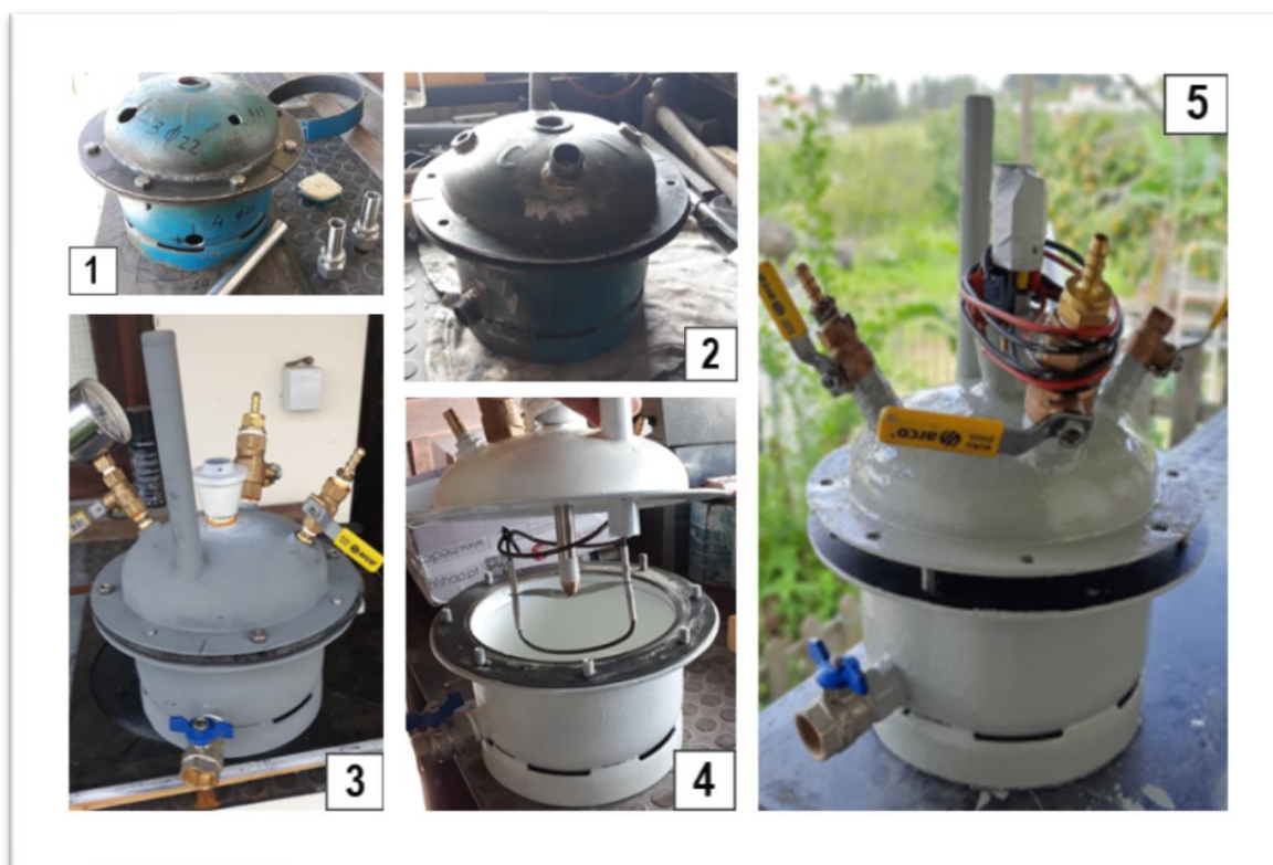
Figura 32 - Fases de construção do digestor anaeróbio.
