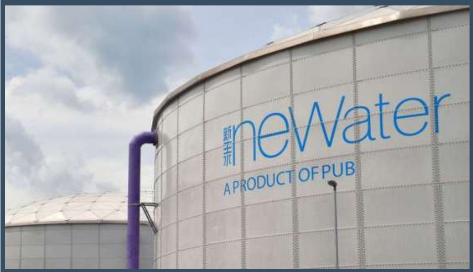
Uso Industrial NEWater, Cingapura
