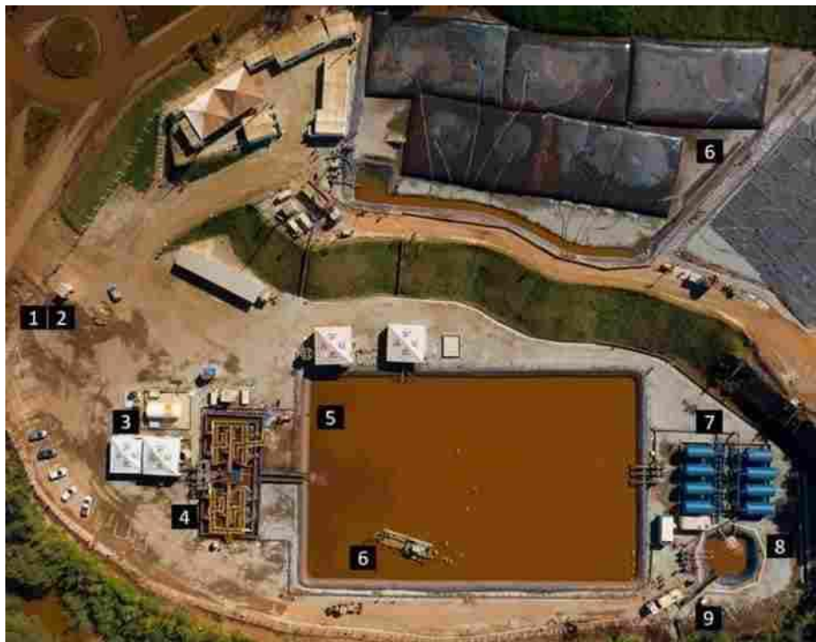
Figura 7 – Foto e fluxograma da ETA. Fonte: Acervo fotográfico da empresa Allonda Ambiental – 2019.
