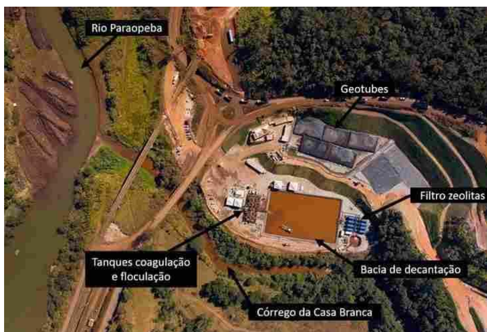
Figura 5 – ETAF localizada na Estrada Alberto flores S/N, Fazenda Iracema - Brumadinho – MG. Fonte: Acervo fotográfico da empresa Allonda Ambiental, 2019.
