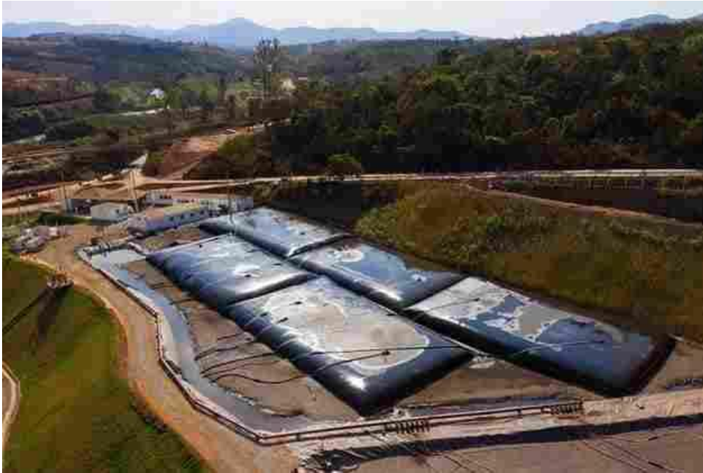
Figura 6 - Bags geotêxtil – desaguamento. Fonte: Acervo fotográfico da empresa Allonda Ambiental, 2019.
