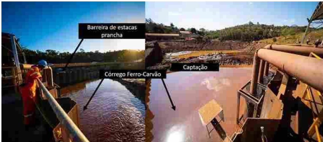
Figura 3 - Barreira de estacas prancha e captação. Fonte: Acervo fotográfico da empresa Allonda Ambiental, 2019.
