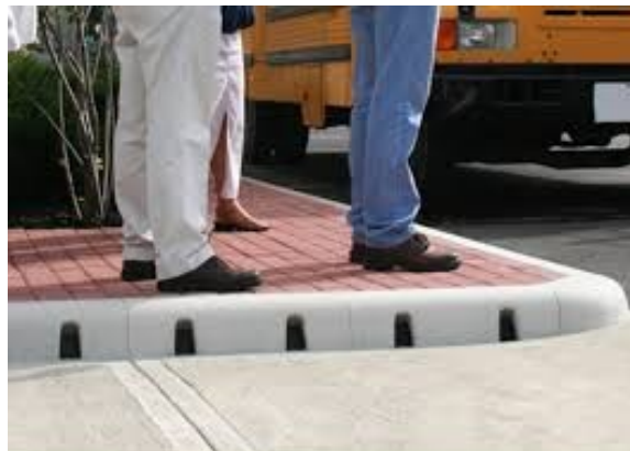
Imagem 5: Técnica de meio-fio sustentável
