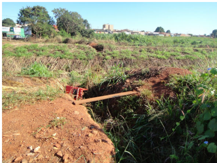
Imagem 9 – Erosão no Córrego do Sapo
