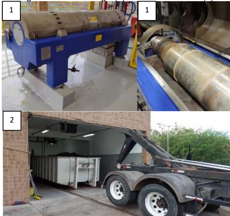
Figura 26 – Centrífuga (1) e retirada de lodo (2).
