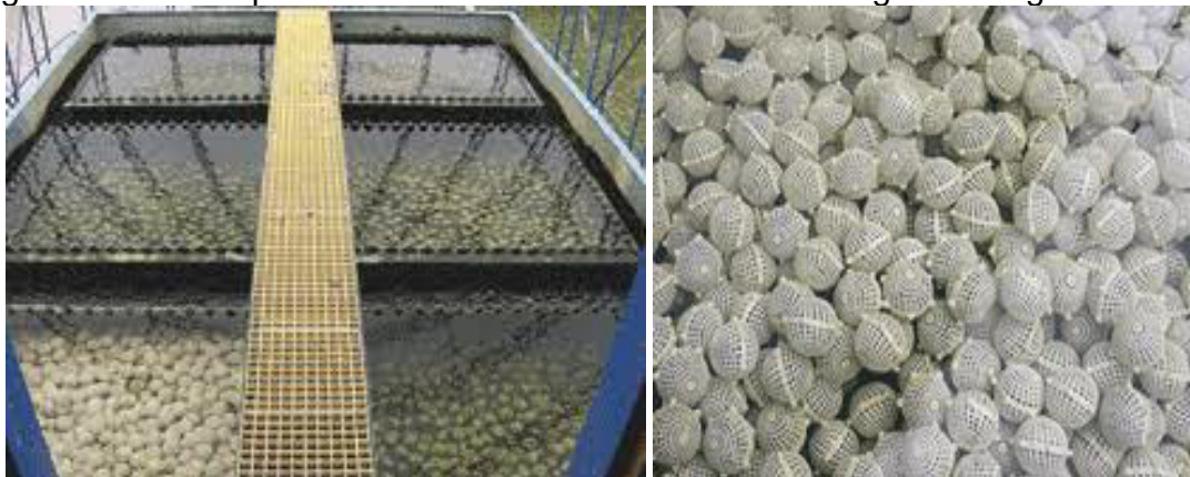
Figura 37 – Exemplo de mídias biofiltro utilizadas na filtragem biológica de RAS.
