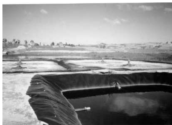
Foto 1 - Lagoas Anaeróbica, Aeróbica e de Decantação.
