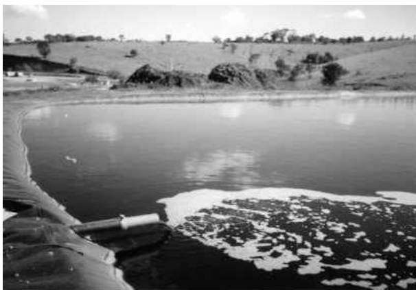
Foto 2 - Chorume chegando do aterro para o tratamento
