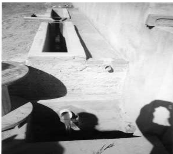
Foto 3 - Chorume já tratado
