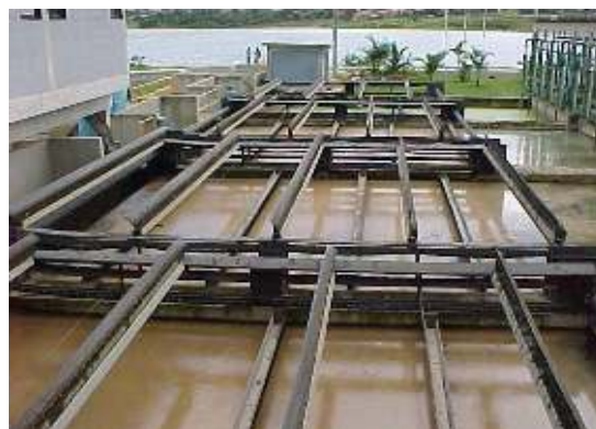
Figura 5.26 – Raspadores de superfície das câmaras de flotação.
