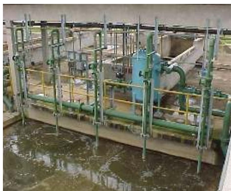
Figura 5.25 – Dispersão de ar na câmara de flotação
