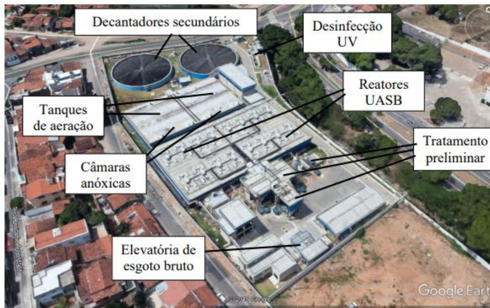
Figura 2 - Unidades de tratamento do esgoto da ETE do Baldo
