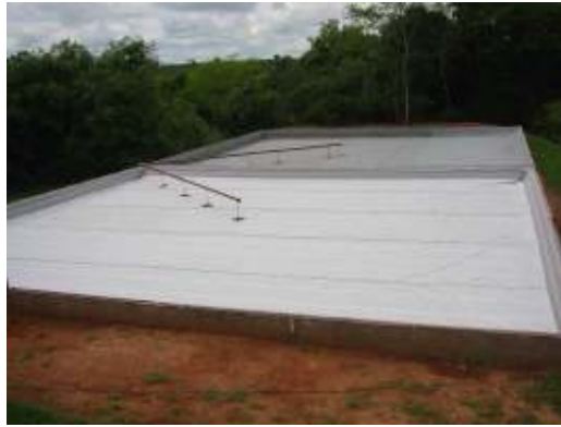
Foto 2. Módulos de Leito de Drenagem em carga – ETE São João das Duas Pontes
