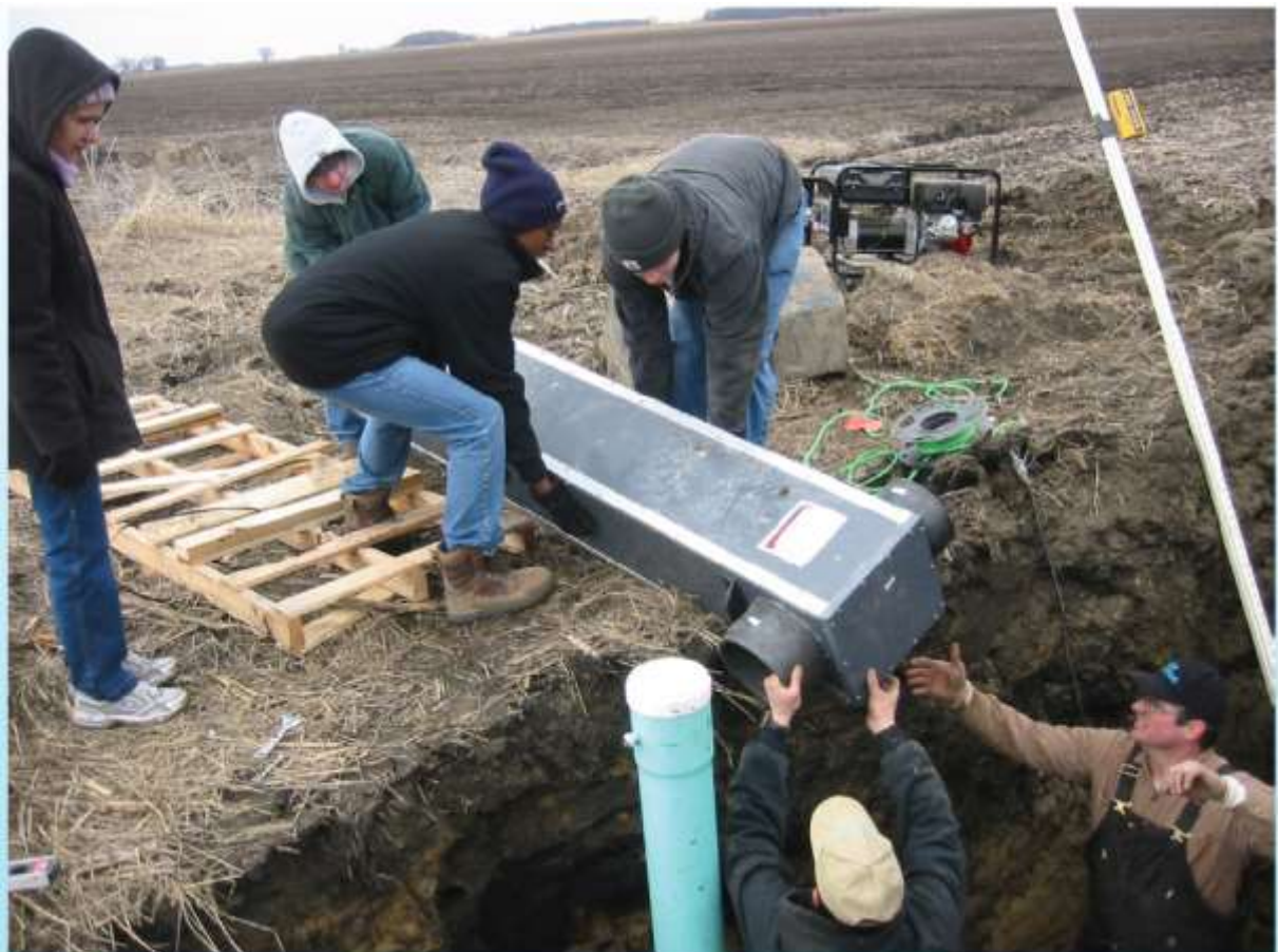
Figura 16 - Instalação da Estrutura de Controle
