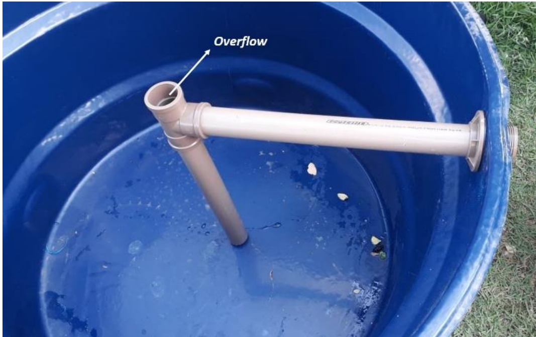
Figura 5 - Overflow para sucção de dejetos sob pressão atmosférica. Fonte: Autor.
