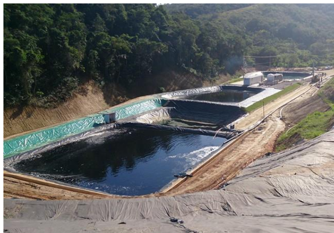
Figura 5 - Lagoa de depósito de chorume.
