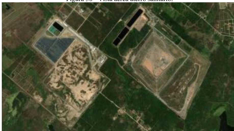
Figura 30 - Vista aérea aterro sanitário.
