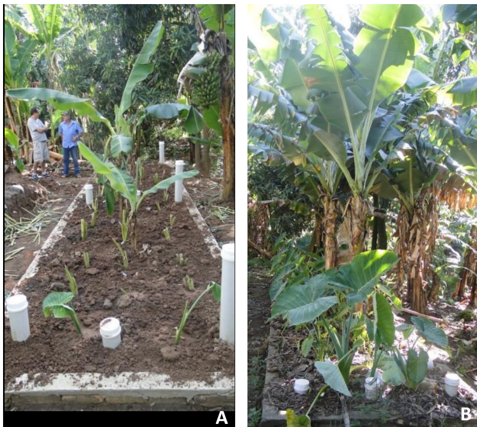
Figura 7.7. Imagens de Bacias de evapotranspiração implantada em Pedra Branca (Campinas/SP) e do desenvolvimento das mudas de bananeira e taioba plantadas. A) BET em início da operação. B) BET com 13 meses de operação.
