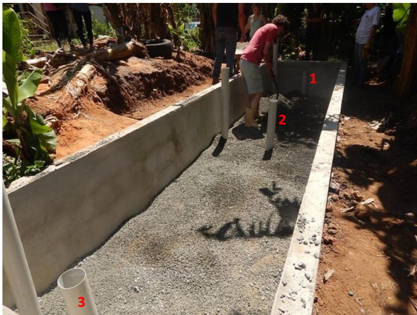
Figura 7.4. BET em fase de construção, durante etapa da elaboração da camada de entulho. É possível ver os tubos de inspeção na entrada (1), no meio (2) e na saída (3) da BET.
