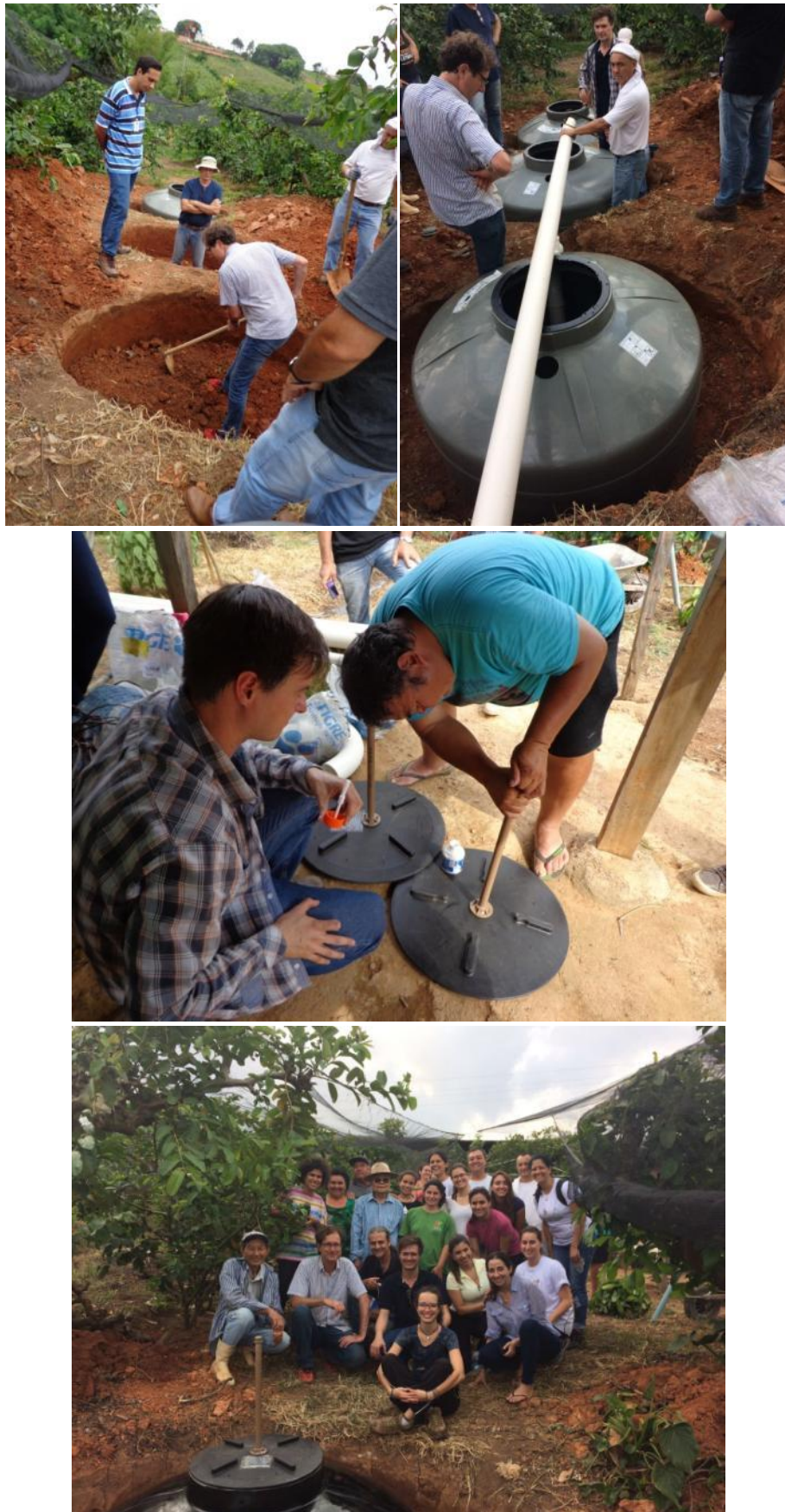
Figura 5.6. Imagens do mutirão de construção da fossa séptica biodigestora (FSB) realizado em 02/12/2016 com 30 participantes.
