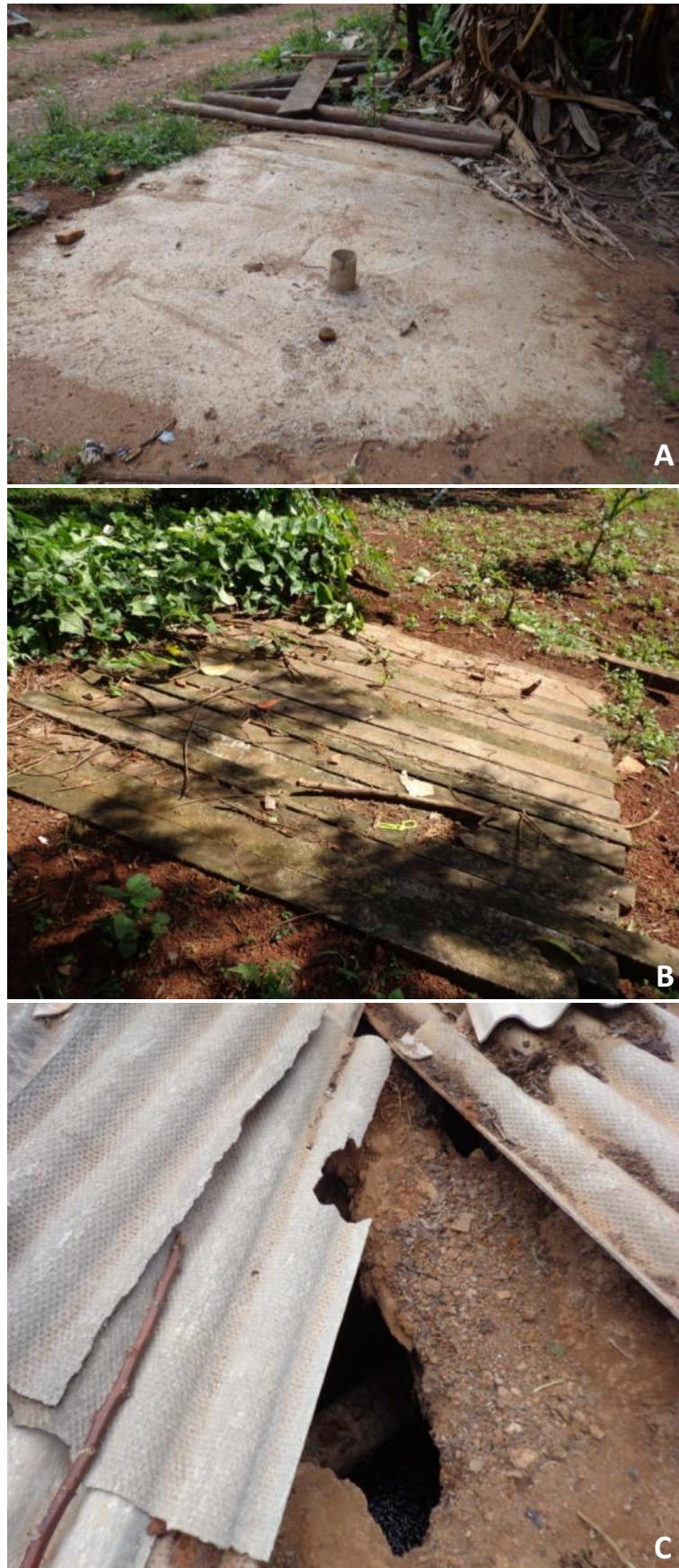
Figura 4.12. Diferentes tipos de tampa para fossas rudimentares. A) Tampa de alvenaria (concreto armado). B) Tampa de madeira. C) Tampa com telhas tipo Brasilit.
