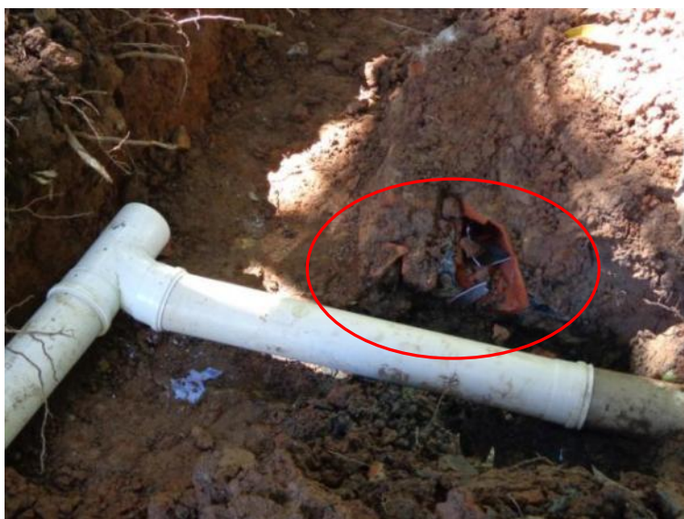
Figura 8.12. Nova tubulação de PVC instalada para alimentar o sistema de tratamento
