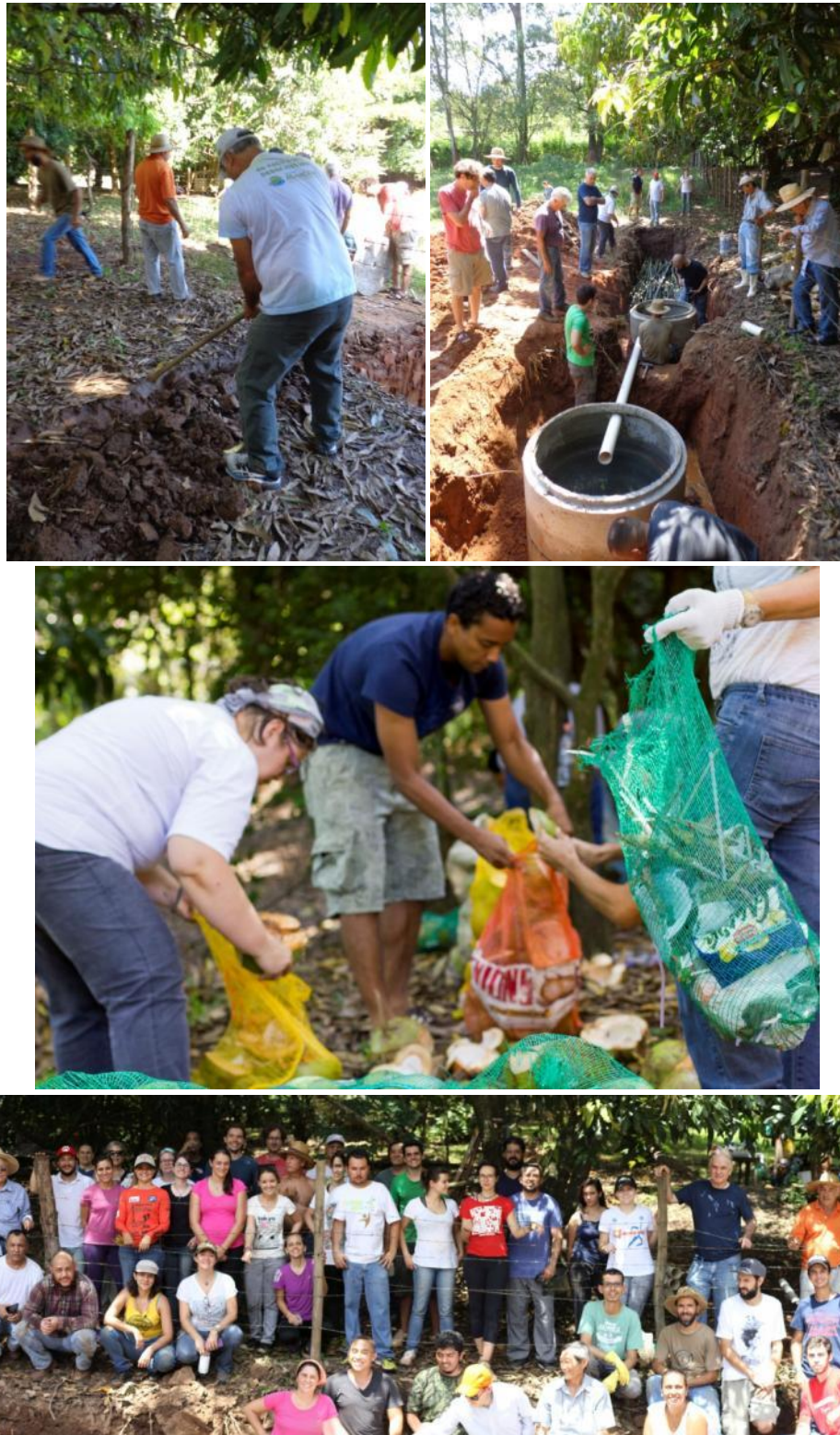
Figura 5.7. Imagens do mutirão de construção do tanque séptico seguido de filtro anaeróbio com recheio de coco verde realizado em 11/03/2017 com 47 participantes.
