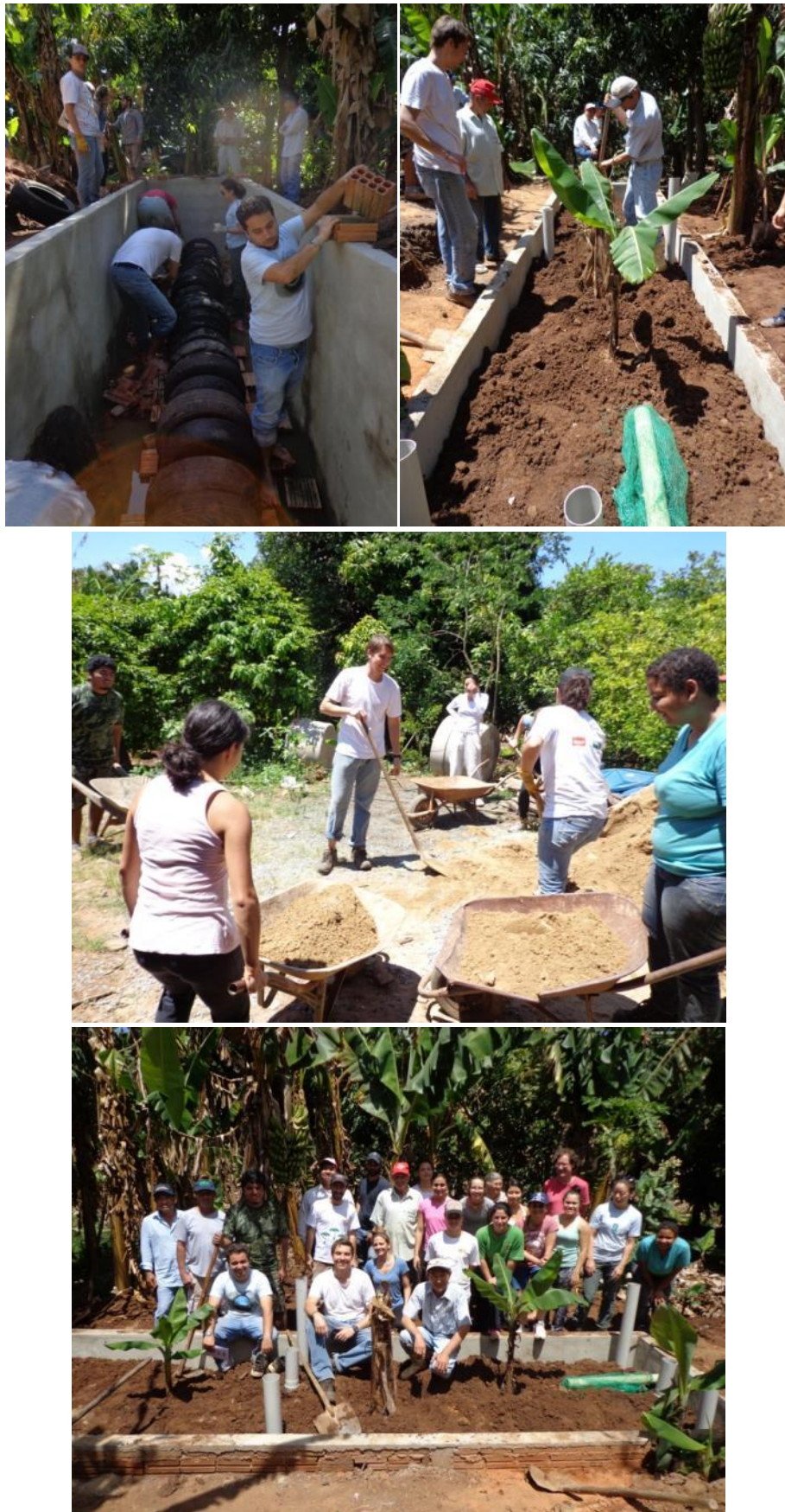
Figura 5.5. Imagens do mutirão de construção da bacia de evapotranspiração (BET) realizado em 08/10/2016 com 27 participantes.
