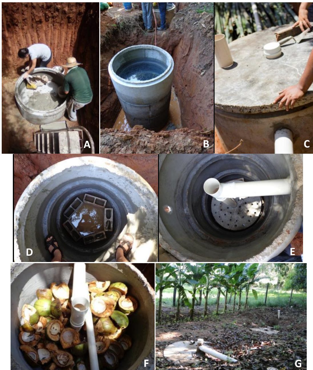
Figura 8.3. Imagens da construção do sistema tanque séptico + filtro anaeróbio em Pedra Branca, Campinas-SP. A) Instalação do anel de fundo do T_{sep} e sua impermeabilização. B) Teste de estanqueidade com o T_{sep} . C) Tampa de concreto e tubulação de inspeção (PVC 100 mm) no T_{sep} . D) Blocos de apoio pra o fundo falso no FA. E) Fundo falso e tubulação de alimentação no filtro já posicionados adequadamente. F) recheio do FA feito com coco verde em pedaços. G) Vista geral do sistema em uso.
