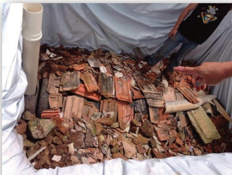
Figura 5.10. Sistemas de tratamento de esgoto implantados espontaneamente à partir da participação nas oficinas. A) Vala de bambu para tratamento de águas cinzas (Sérgio Shimoda). B) Bacia de evapotranspiração para tratamento de águas de vaso sanitário (Karoline Nakamura).
