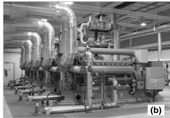
Figura 4-16: Motores de combustão interna movidos a biogás: (a) Série QSV91 – 1.250 a 2.000 kW – Cummins; (b) Jenbacher modelo J320 GS – 3.000 kW – General Electric
