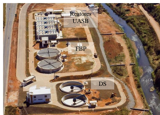
Figura 5-5: Vista geral das unidades da ETE Laboreaux
