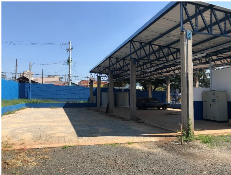
Figura 40 – Estrutura metálica com piso em concreto a direita e pátio com piso intertravado a esquerda.
