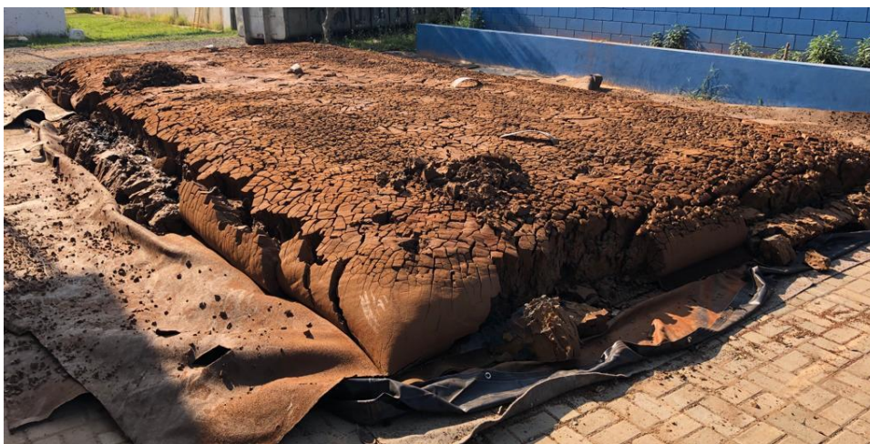
Figura 108 – SCR-S após o período de consolidação, aberto e pronto para ser removido.
