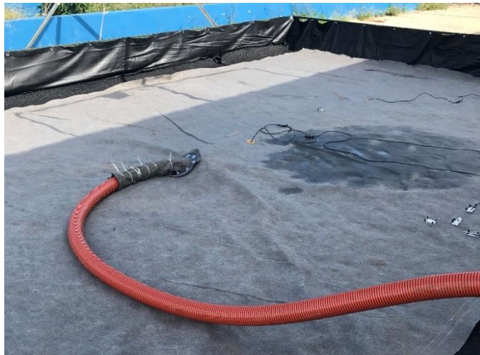
Figura 9 – Com o acionamento da bomba, inicia-se o enchimento do tubo geotêxtil, que imediatamente após, começa a desaguar.
