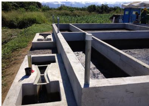
Figura 3: Caixa de retenção de borras e calha Parshall, situados a montante do sistema de lagoas em série da ETE.
