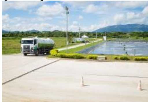
Figura 2: Chegada de caminhão auto vácuo a ETE.
