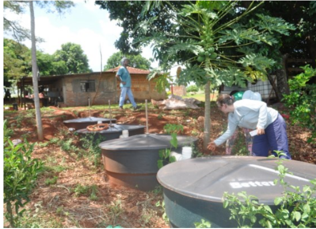
Figura 5 – Construção da Tecnologia Social Fossa Séptica Biodigestora (São Paulo)
