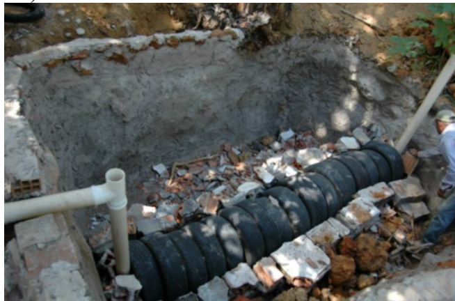
Figura 9 – Construção da Tecnologia Social de Saneamento Círculo de Bananeiras (Espírito Santo e Brasília)
