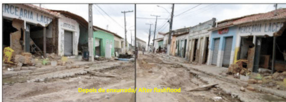
Figura 1: Desastre devido à enxurrada na cidade de Lajedinho, Bahia, dezembro/2013.
