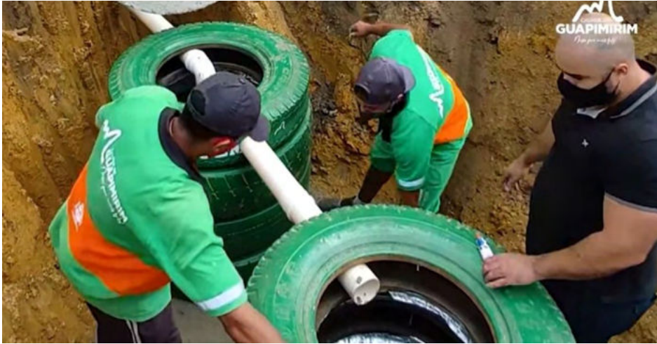
Figura 13: Fossa, filtro e sumidouro com pneus.
