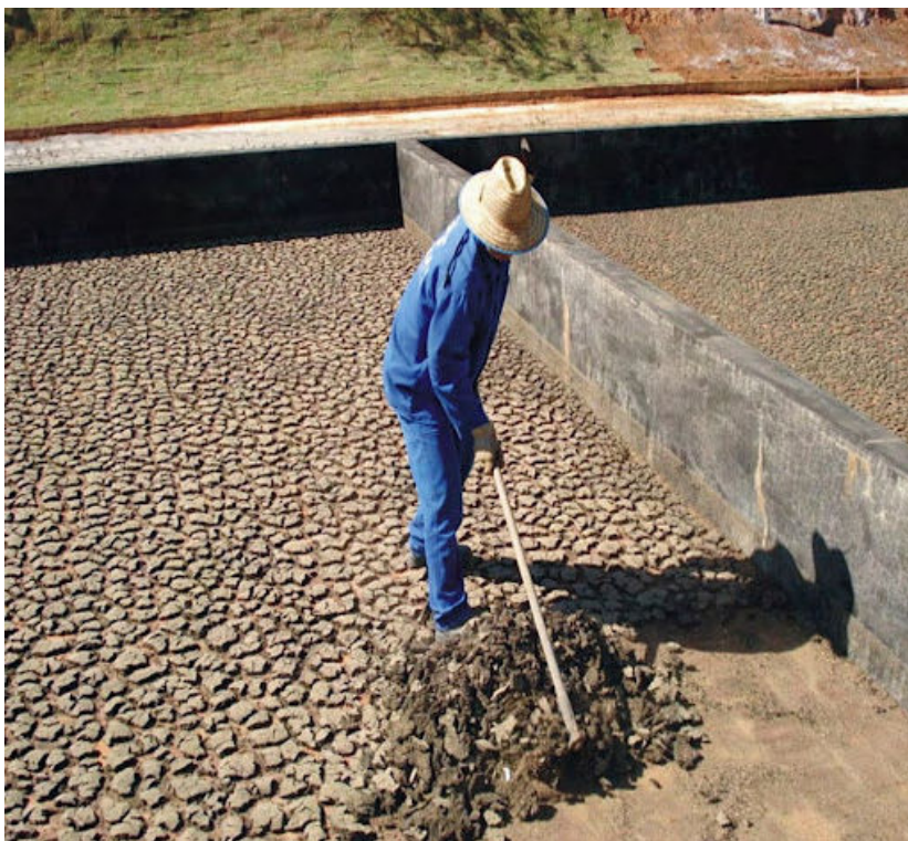
Figura 17: Leito de secagem de lodo.
