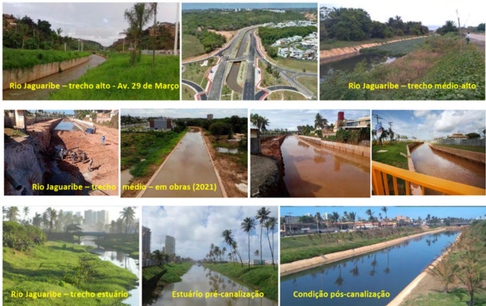
Figura 11: Trechos das intervenções no curso principal do Rio Jaguaribe (Salvador, Bahia).
