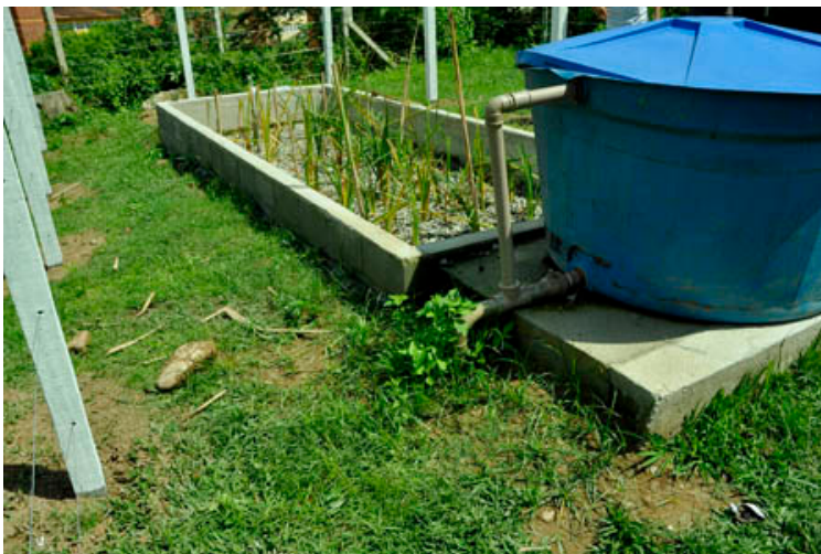
Figura 8: Estação de Tratamento de Esgotos (ETE) através de zona de raízes em Angra dos Reis (RJ).
