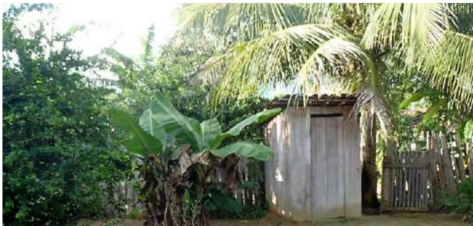
Figura 2: Fossa seca construída em madeira.
