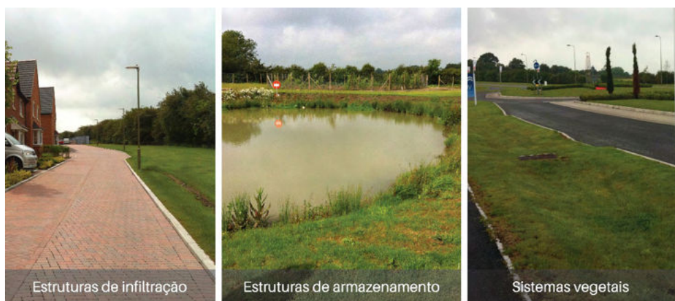
Figura 5: Exemplo de intervenções estruturais de BMP em um condomínio em Oxfordshire, Reino Unido 3
