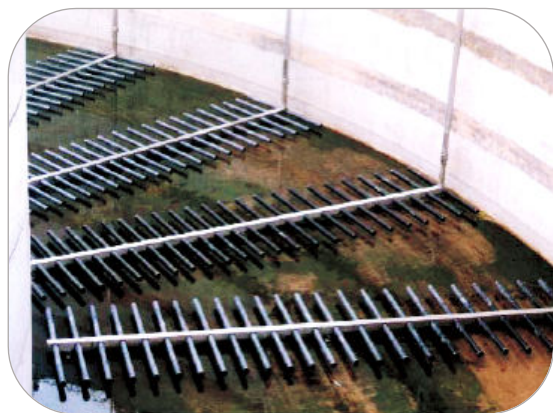
BOLHA FINA: DIFUSOR TUBULAR ( FIXO OU REMOVÍVEL )
