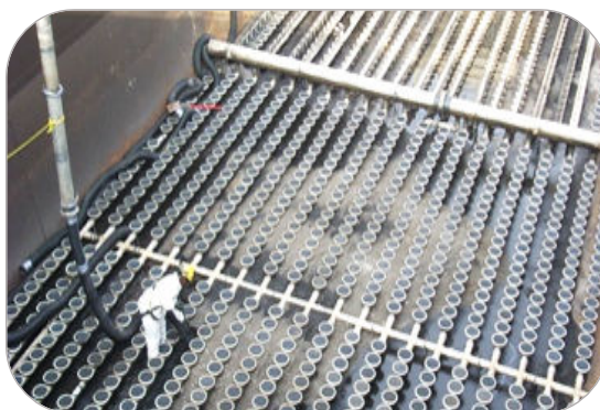
BOLHA FINA: DIFUSOR POR DISCO ( FIXO OU REMOVÍVEL )
