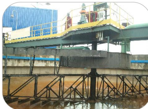
**RASPADOR DE FUNDO COM LEVANTAMENTO DE BRAÇO**
