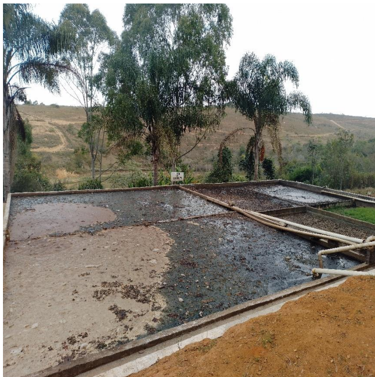
Figura 1 – Lodo de ETE acondicionado no leito de secagem.
