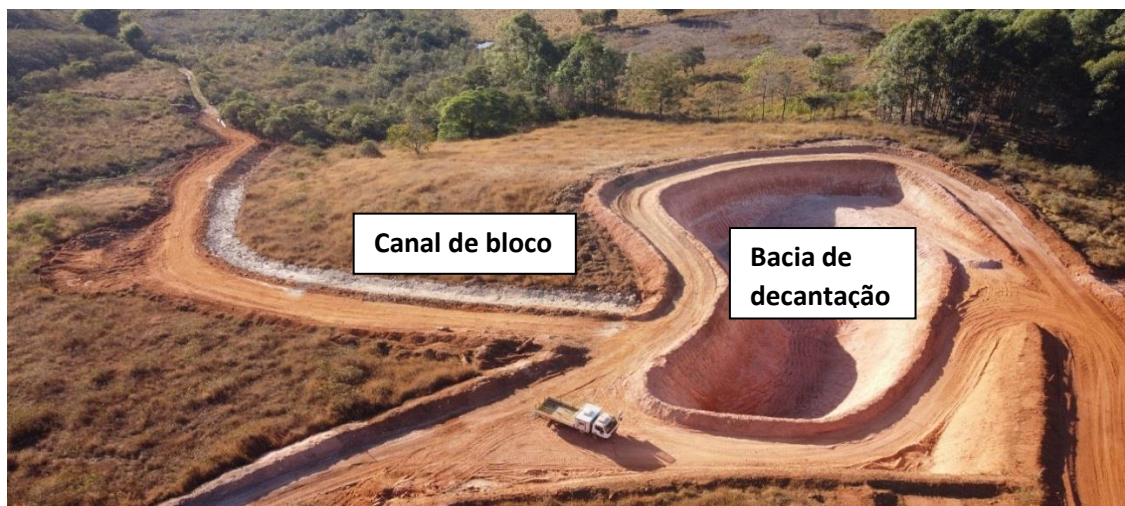
Figura 9: Canal de blocos e bacia de decantação
