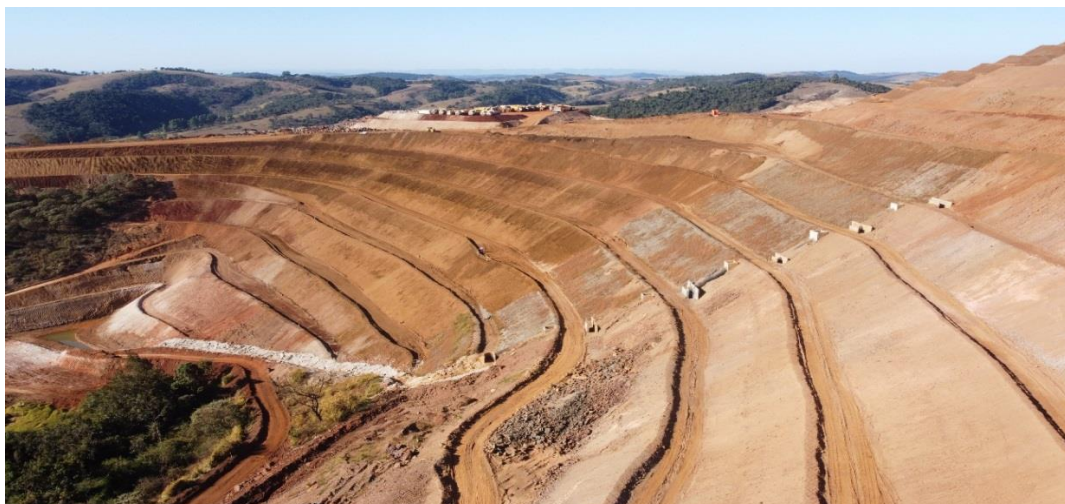
Figura 1: Imagem lateral da drenagem superficial da mina de ferro
