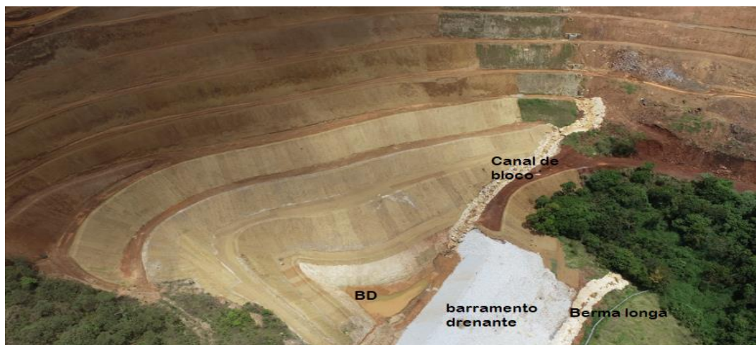
Figura 3: Imagem geral da drenagem superficial da mina
