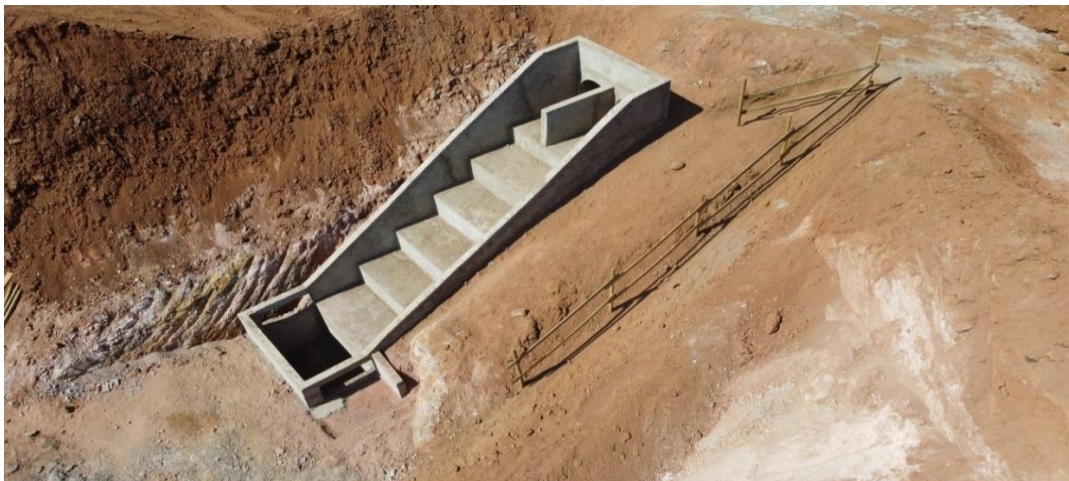
Figura 7: Escada na pilha de rejeito
