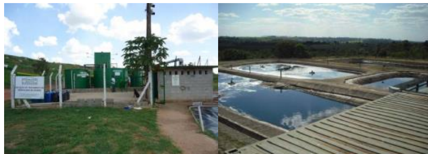
Figura 17. Vista da ETE de Percolado do Aterro
