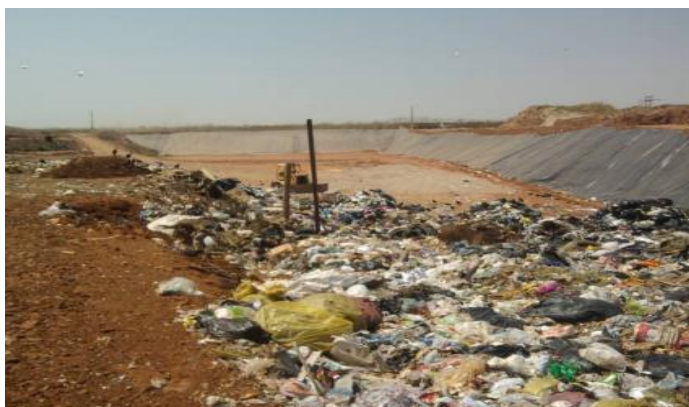
Figura 11. Revestimento da manta de PEAD nas laterais dos taludes
