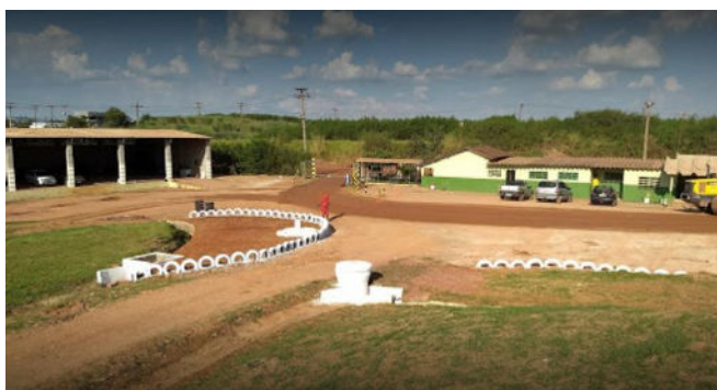
Figura 9. Visão da entrada do Aterro Sanitário de Rio Claro
