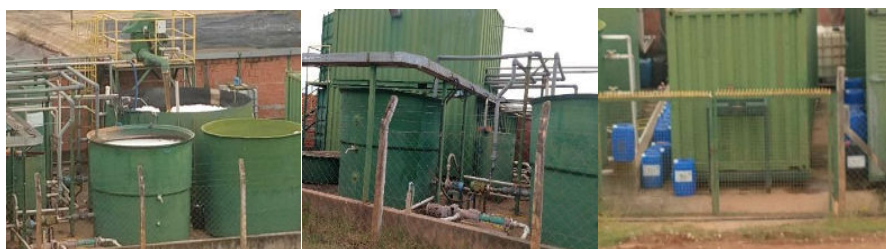
Figura 20. Reservatório, container e vasilhames
