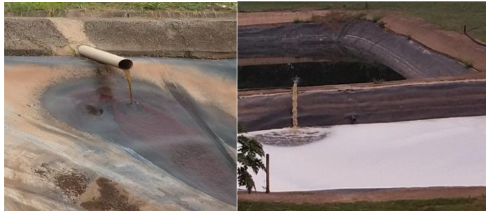
Figura 18. Vista das lagoas de lixiviado
