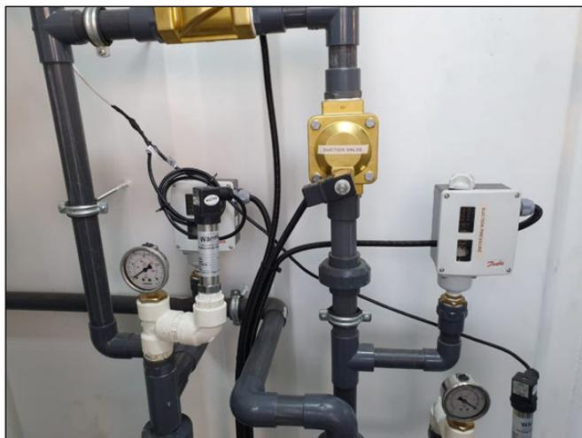
**Figura 4: Sensores de pressão negativa e recalque instalados na estação de tratamento de efluentes<sup>2</sup>**
