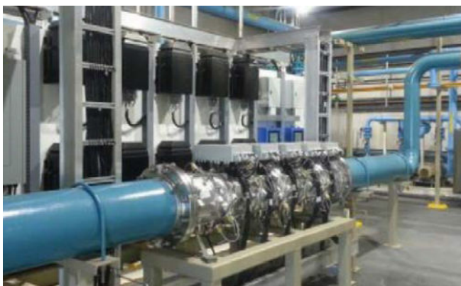
Tratamento pré-osmose reversa desinfecção e descloração
