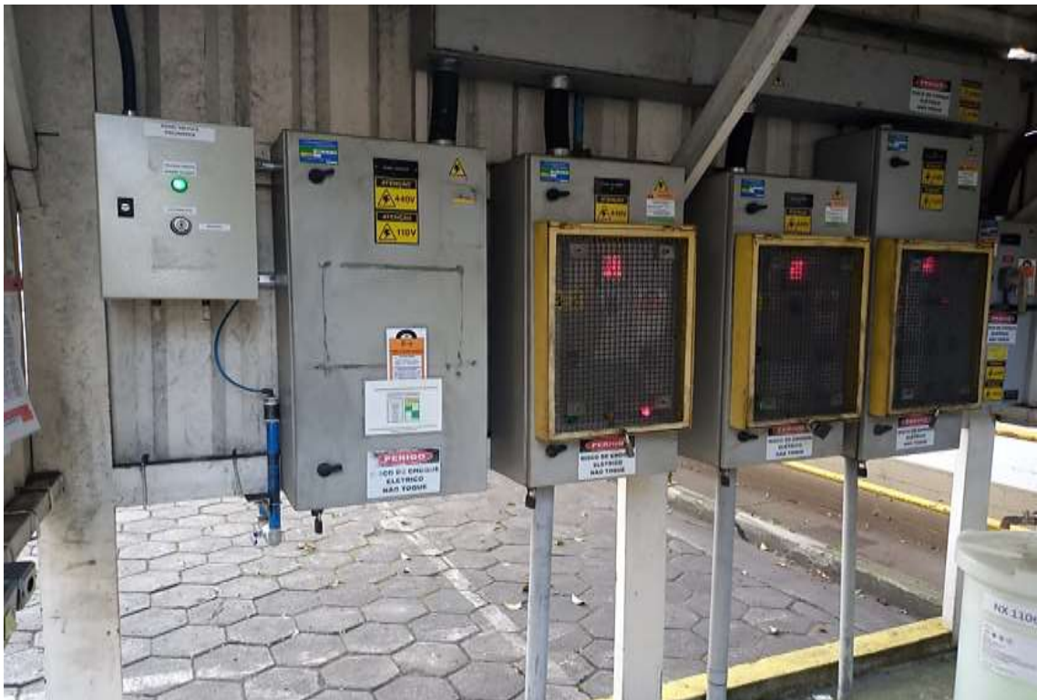
Figura 5.1 - Implementação do Painel Elétrico Auxiliar ao Lado do Quadro Principal das Bombas Elétricas.
