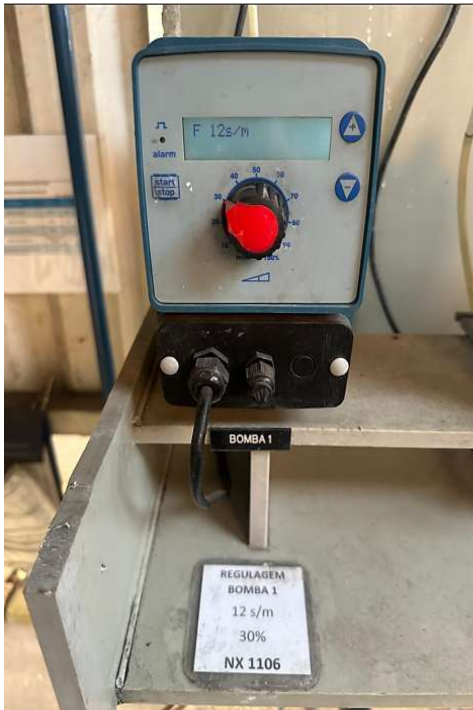
Figura 4.2 - Regulagem da Bomba de Dosagem Tekba - Seko 1 (12 s/m pulso)
