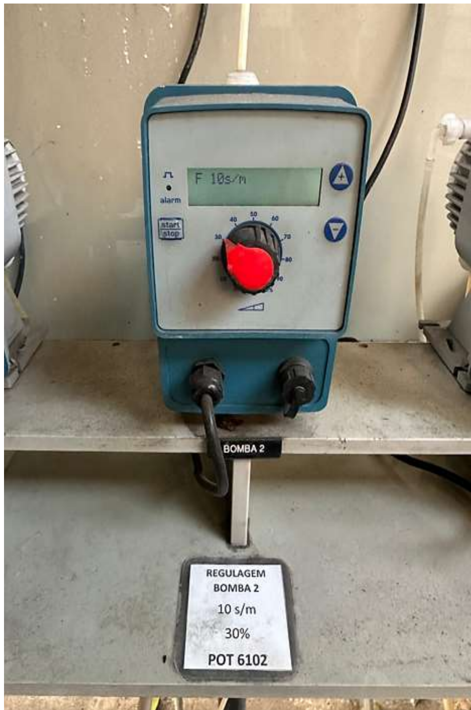
Figura 4.3 - Regulagem da Bomba de Dosagem Tekba - Seko 2 (10 s/m pulso)
